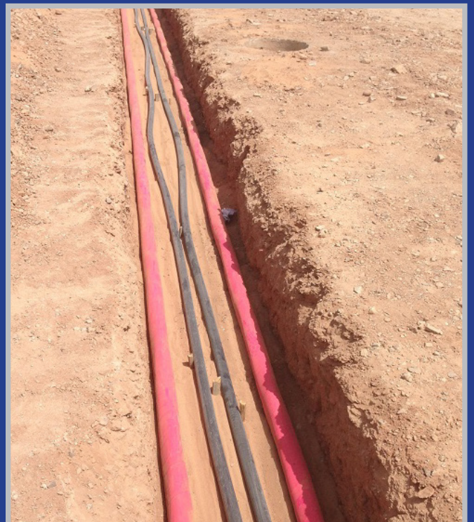
أعمال شبكات المياه - خيبر
