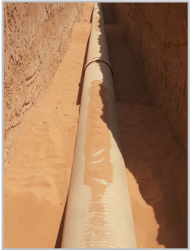
أعمال شبكات المياه - خيبر
